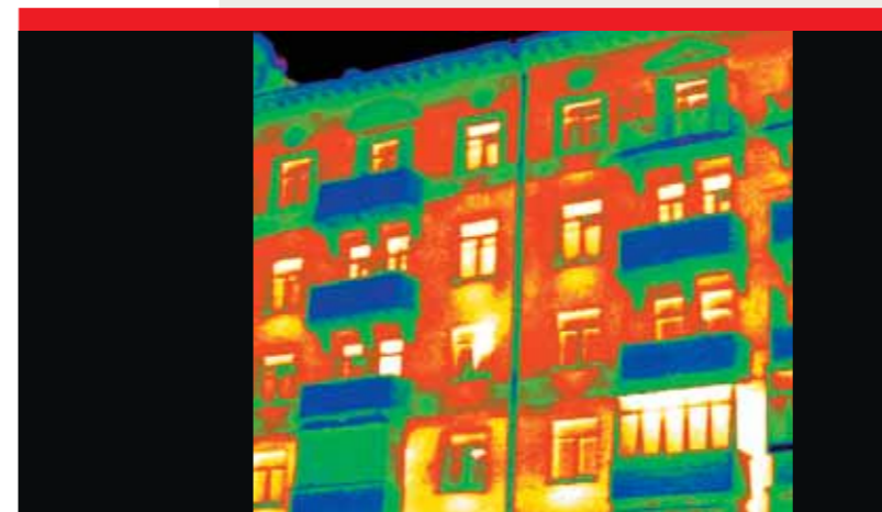
Тепловизионный снимок фасада жилого панельного здания
